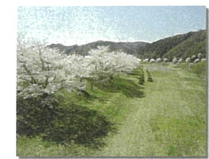
33-4/三刀屋川右岸新三刀屋橋～坂山橋
